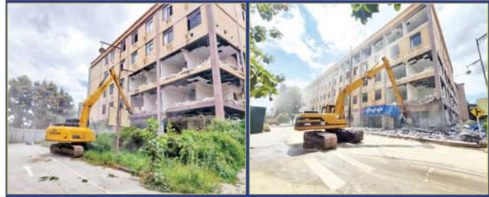
ရွှေကုက္ကိုလ်နယ်မြေ ဒုတိယပိုင်းအတွင်းရှိ အွန်လိုင်းလိမ်လည်လောင်းကစားမှုကျူးလွန်ရာတွင် အသုံးပြုသည့် တရားမဝင်အဆောက်အအုံများအား ယန္တရားဖြင့် ဖြိုချဖျက်ဆီးမှုကို တွေ့ရစဉ်။
