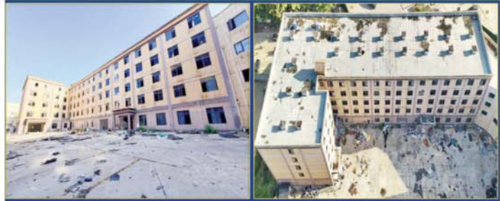
ရွှေကုက္ကိုလ်နယ်မြေ ဒုတိယပိုင်းအတွင်းရှိ အွန်လိုင်းလိမ်လည်လောင်းကစားမှုကျူးလွန်ရာတွင် အသုံးပြုသည့် တရားမဝင်အဆောက်အအုံများအား ဖြိုချဖျက်ဆီး တွေ့ရစဉ်။
