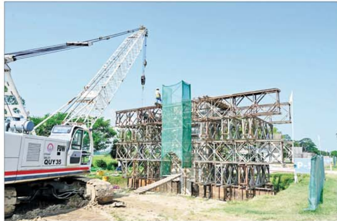
ရွှေပြည်တော်ဝင်လမ်းပေါ်ရှိ နေပြည်တော် - တောင်တွင်းကြီး မီးရထားလမ်း ခုံးကျော်တံတား တည်ဆောက်ရေးလုပ်ငန်းခွင်ကို တွေ့ရစဉ်။
