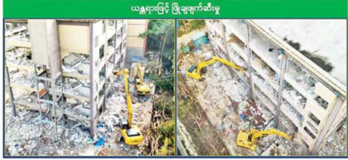
ရွှေကုက္ကိုလ်နယ်မြေ ဒုတိယပိုင်းအတွင်းရှိ အွန်လိုင်းလောင်းကစားမှု ကျူးလွန်ရာတွင် အသုံးပြုခဲ့သည့် ၅ ထပ် အဆောက်အအုံအား စနစ်တကျဆက်လက်ဖြိုချဖျက်ဆီးလျက်ရှိမှု
