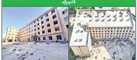
ရွှေကုက္ကိုလ်နယ်မြေ ဒုတိယပိုင်းအတွင်းရှိ အွန်လိုင်းလောင်းကစားမှု ကျူးလွန်ရာတွင် အသုံးပြုခဲ့သည့် ၅ ထပ် အဆောက်အအုံအား စနစ်တကျဆက်လက်ဖြိုချဖျက်ဆီးမှု
