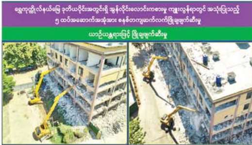
ရွှေကုက္ကိုလ်နယ်မြေ ဒုတိယပိုင်းအတွင်းရှိ အွန်လိုင်းလောင်းကစားမှု ကျူးလွန်ရာတွင် အသုံးပြုသည့် ၅ ထပ်အဆောက်အအုံအား စနစ်တကျဆက်လက်ဖြိုချဖျက်ဆီးမှု
