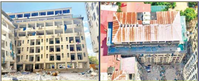
ရွှေကုက္ကိုလ်နယ်မြေ ဒုတိယပိုင်းအတွင်းရှိ အွန်လိုင်းလောင်းကစားမှု ကျူးလွန်ရာတွင် အသုံးပြုသည့် တရားမဝင် ၆ ထပ်အဆောက်အအုံအား မဖြိုချဖျက်ဆီးတော့ရစဉ်။
