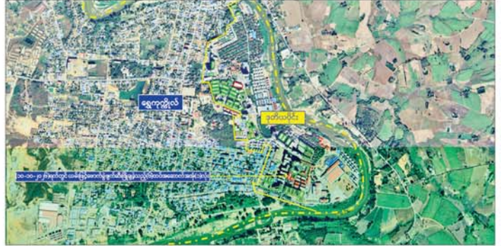
ရွှေကုက္ကိုလ်နယ်မြေ ဒုတိယပိုင်းအတွင်းရှိ အွန်လိုင်းလောင်းကစားမှု ကျူးလွန်ရာတွင် အသုံးပြုသည့် တရားမဝင် အဆောက်အအုံများအား စနစ်တကျဖြိုချဖျက်ဆီးမှု။
