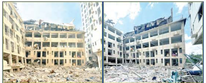
ရွှေကုက္ကိုလ်နယ်မြေ ဒုတိယပိုင်းအတွင်းရှိ အွန်လိုင်းလောင်းကစားမှု ကျူးလွန်ရာတွင် အသုံးပြုသည့် တရားမဝင် ၆ ထပ်အဆောက်အအုံအား ဖြိုချဖျက်ဆီးပြီးတော့ရစဉ်။
