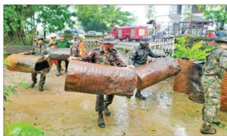
လှိုင်းဘွဲ့ချောင်းကမ်းပါး၌ ရေထိန်းတံစံငယ်ဆောင်ရွက်နေမှုကို တွေ့ရစဉ်။
