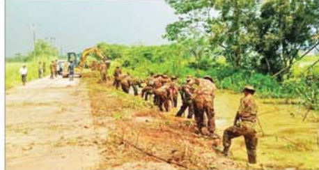
လှည်းကူးမြို့နယ် ဆီဆုံကုန်းကျေးရွာ လမ်းဘေးဝဲယာတစ်လျှောက် ရေစီးရေလာကောင်းမွန်စေရေး ဆောင်ရွက်စဉ်။
