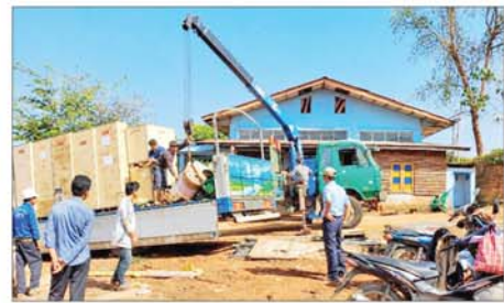
သီပေါမြို့နယ် ၃၃/၁၁ကေဗွီ ၁၀ အမီဗို့အ သီပေါဓာတ်အားခွဲရုံတွင် ပျက်စီးနေသော ဓာတ်အားခွဲရုံပစ္စည်းများ အသစ်အစားထိုးပြုပြင်တည်ဆောက်ခြင်းလုပ်ငန်း ဆောင်ရွက်နေမှုကို တွေ့ရစဉ်။
