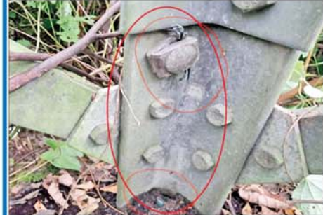
ဓာတ်အားပို့လွှတ်သည့်တာဝါတိုင်များတွင် တပ်ဆင်ထားသည့် မြေစိုက်ကြိုး (Earth Wire) များဖြတ်၍ ခိုးယူခံထားရမှုကို တွေ့ရစဉ်။ တာဝါတိုင်များအခြေတွင် သံပေါင်များ၊ ဘို့နပ်များဖြတ်၍ ခိုးယူခံထားရမှုကို တွေ့ရစဉ်။ သံပေါင်များ၊ ဘို့နပ်များ ခိုးယူခြင်းမခံရစေရန်အတွက် ကပေါဆော်၍ တွဲဆက်နေမှုကို တွေ့ရစဉ်။
