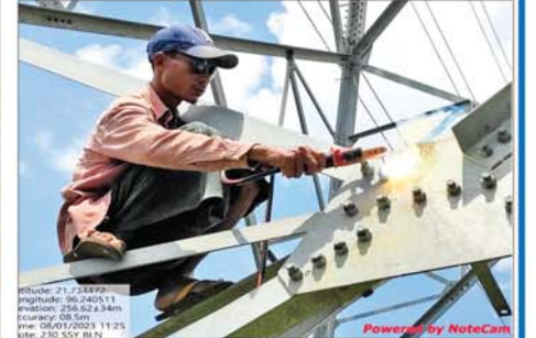
ဓာတ်အားပို့လွှတ်သည့်တာဝါတိုင်များတွင် တပ်ဆင်ထားသည့် မြေစိုက်ကြိုး (Earth Wire) များဖြတ်၍ ခိုးယူခံထားရမှုကို တွေ့ရစဉ်။ တာဝါတိုင်များအခြေတွင် သံပေါင်များ၊ ဘို့နပ်များဖြတ်၍ ခိုးယူခံထားရမှုကို တွေ့ရစဉ်။ သံပေါင်များ၊ ဘို့နပ်များ ခိုးယူခြင်းမခံရစေရန်အတွက် ကပေါဆော်၍ တွဲဆက်နေမှုကို တွေ့ရစဉ်။
