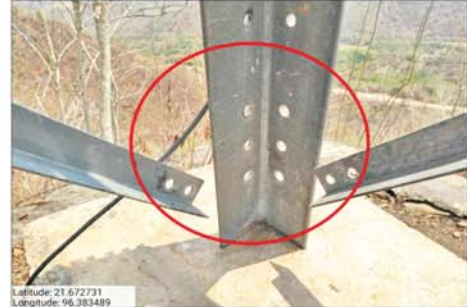
ဓာတ်အားပို့လွှတ်သည့်တာဝါတိုင်များတွင် တပ်ဆင်ထားသည့် မြေစိုက်ကြိုး (Earth Wire) များဖြတ်၍ ခိုးယူခံထားရမှုကို တွေ့ရစဉ်။ တာဝါတိုင်များအခြေတွင် သံပေါင်များ၊ ဘို့နပ်များဖြတ်၍ ခိုးယူခံထားရမှုကို တွေ့ရစဉ်။ သံပေါင်များ၊ ဘို့နပ်များ ခိုးယူခြင်းမခံရစေရန်အတွက် ကပေါဆော်၍ တွဲဆက်နေမှုကို တွေ့ရစဉ်။
