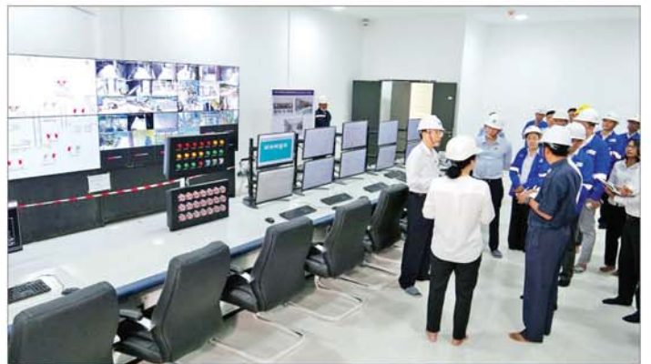
သန်လျင်ရေနံချက်စက်ရုံ စီမံကိန်းအပိုင်း(၁)အား စက်ရုံလည်ပတ်မှုနည်းစဉ် တစ်ဆင့်ချင်းအလိုက် စမ်းသပ်လည်ပတ်နေမှုကို တာဝန်ရှိသူများ ကြည့်ရှုစစ်ဆေးစဉ်။
