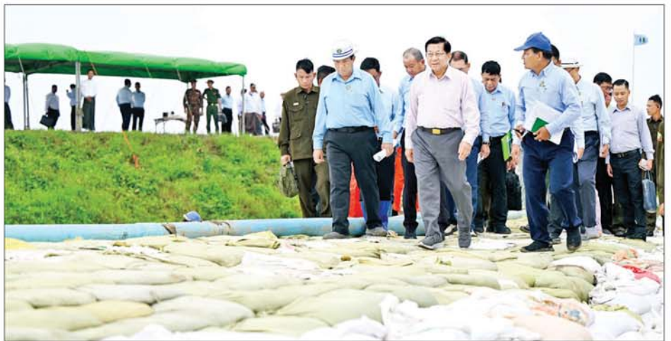
နိုင်ငံတော်သမ္မတ ဦးမင်းအောင်လှိုင် ဧရာဝတီတိုင်းဒေသကြီး ညောင်တုန်းမြို့နယ် ဂန်ချောင်းကျေးရွာအနီး ညောင်တုန်းကျွန်းတာ (ဧရာဝတီမြစ်ခွဲ) တာကိုယ်ထည်ရေတိုက်စားခံရမှု တားဆီးကာကွယ်ရေးလုပ်ငန်းများ ဆောင်ရွက်နေမှုကို ကြည့်ရှုစစ်ဆေးစဉ်။
