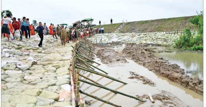
ဧရာဝတီတိုင်းဒေသကြီး ညောင်တုန်းမြို့နယ် ဂန်ချောင်းကျေးရွာအနီး ညောင်တုန်းကျွန်းတာ(ဧရာဝတီမြစ်ခွဲ) တာကိုယ်ထည်ရေတိုက်စားခံရမှု တားဆီးကာကွယ်ရေးလုပ်ငန်းများ ဆောင်ရွက်နေမှုကို တွေ့ရစဉ်။
