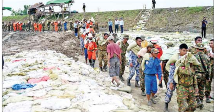
ဧရာဝတီတိုင်းဒေသကြီး ညောင်တုန်းမြို့နယ် ဂန်ချောင်းကျေးရွာအနီး ညောင်တုန်းကျွန်းတာ(ဧရာဝတီမြစ်ခွဲ) တာကိုယ်ထည်ရေတိုက်စားခံရမှု တားဆီးကာကွယ်ရေးလုပ်ငန်းများ ဆောင်ရွက်နေမှုကို တွေ့ရစဉ်။
