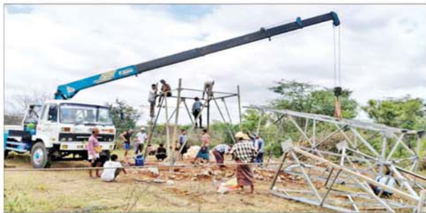
၁၃၂ ကေစီ ညောင်ပင်ကြီး - ဗုဒ္ဓကုန်း မဟာဓာတ်အားလိုင်း တာဝါတိုင်အမှတ် (၃၃၈) ဖောက်ခွဲဖျက်ဆီးခံရမှုကြောင့် ပြုလုပ်ပျက်စီးမှုကို ပြန်လည်ပြုပြင်ဆောင်ရွက်နေစဉ်။
