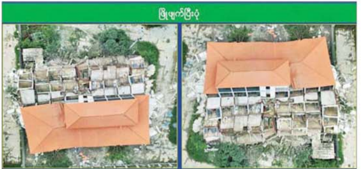
ကရင်ပြည်နယ် မြစ်ဝတံမြို့နယ် ရွှေကုက္ကိုလ်နယ်မြေရှိ အွန်လိုင်းလိမ်လည်လောင်းကစားမှု လုပ်ကိုင်ခဲ့သည့် တရားမဝင် ကိုးထပ်အဆောက်အအုံကို ဖြိုဖျက်ပြီး တွေ့ရစဉ်။
