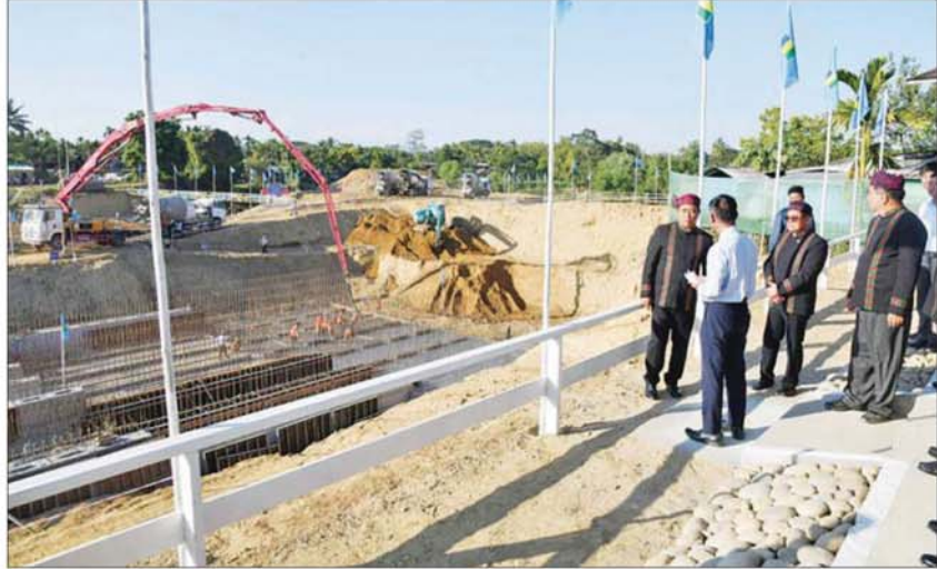
ပြည်ထောင်စုဝန်ကြီး ဦးတင်အောင်စန်း ရေကြည်ချောင်းရေထိန်းတံခါး တည်ဆောက်နေမှုကို ကြည့်ရှုစစ်ဆေးစဉ်။
