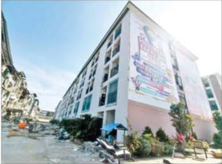
KK Park နယ်မြေအပိုင်း(၃)တွင် တရားမဝင် ဆောက်လုပ်ထားသည့် (၇)ထပ်တိုက်အမှတ် C - 11 အဆောက်အအုံအား မဖြိုဖျက်မီနှင့်ဖြိုဖျက်ပြီး တွေ့ရစဉ်။
