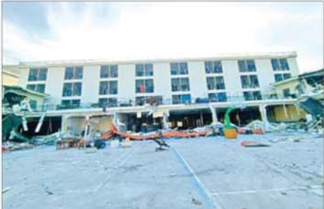
KK Park နယ်မြေအပိုင်း(၃)တွင် တရားမဝင် ဆောက်လုပ်ထားသည့် (၇)ထပ်တိုက် လူနေအဆောက်အအုံအား မဖြိုဖျက်မီနှင့်ဖြိုဖျက်ပြီး တွေ့ရစဉ်။
