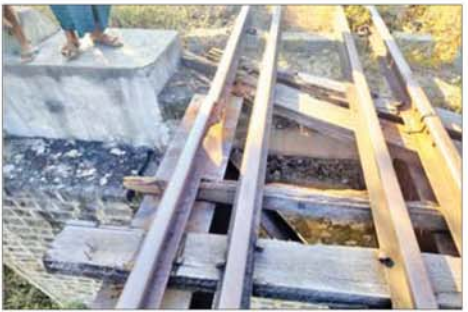
အကြမ်းဖက်သောင်းကျန်းသူအဖွဲ့၏ မိုင်းထောင်ဖောက်ခွဲမှုကြောင့် ပုဂံ-ကျောက်ပန်းတောင်းရထားလမ်းပိုင်းအတွင်း စုတည်နှင့် တောင်ငူဘူတာအကြား (မိုင်တိုင်အမှတ် ၃၈၁/၁၅-၁၆)ရှိ ပေ ၂၀ အရှည် သံပေါင်တံတားပေါ်၌ ရထားသံလမ်းပျက်စီးမှုကို တွေ့ရစဉ်။
