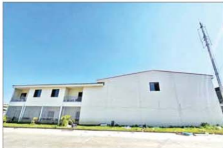
KK Park နယ်မြေ အပိုင်း (၃) တွင် တရားမဝင် ဆောက်လုပ်ထားသည့် နှစ်ထပ်လူနေအဆောက်အအုံအား မဖြိုဖျက်မီနှင့် ဖြိုဖျက်ပြီးနောက် တွေ့ရစဉ်။
