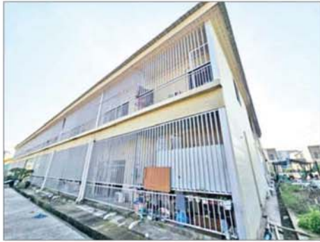
KK Park နယ်မြေ အပိုင်း (၃) တွင် တရားမဝင် ဆောက်လုပ်ထားသည့် နှစ်ထပ်လူနေအဆောက်အအုံအား မဖြိုဖျက်မီနှင့် ဖြိုဖျက်ပြီးနောက် တွေ့ရစဉ်။
