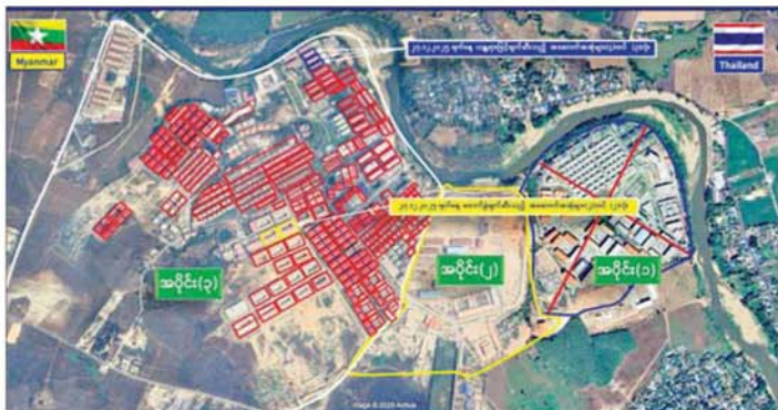
ကရင်ပြည်နယ် မြဝတီမြို့နယ် KK Park အပိုင်း(၃) နယ်မြေအတွင်းရှိ တရားမဝင်အဆောက်အအုံများ ဖောက်ခွဲဖျက်ဆီးမှု။
