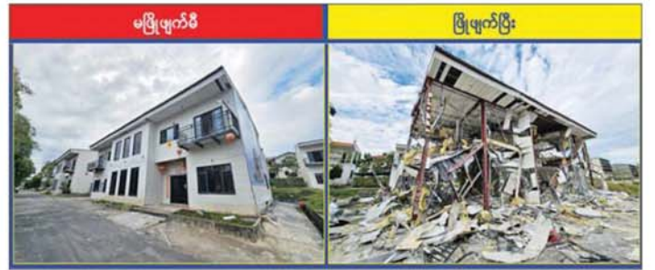
KK Park နယ်မြေအပိုင်း(၃) တွင် တရားမဝင်အဆောက်အအုံများသည် နှစ်ထပ် လူနေအဆောက်အအုံ။
