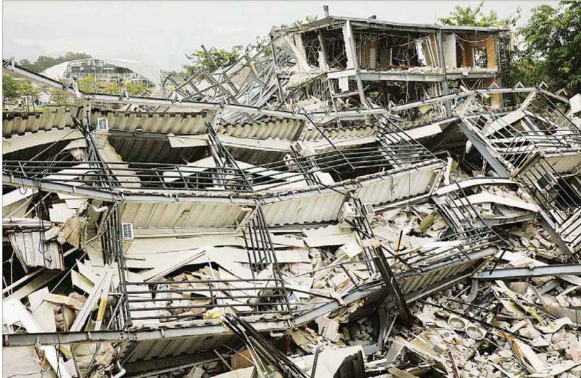
KK Park နယ်မြေအတွင်း အွန်လိုင်းလိမ်လည်မှုများ၊ အွန်လိုင်းလောင်းကစားမှုများနှင့် ဒုစရိုက်မှုများ ကျူးလွန်ခဲ့ကြသည့် ပြည်ပနိုင်ငံသားများ စုဖွဲ့နေထိုင်သော အဆောက်အအုံများ ဖျက်ဆီးရှင်းလင်းထားမှုကို တွေ့ရစဉ်။
