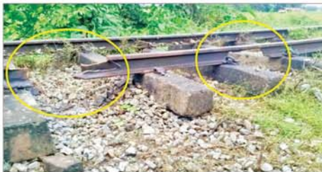
အကြမ်းဖက်သောင်းကျန်းသူအဖွဲ့၏ မိုင်းထောင်ဖောက်ခွဲမှုကြောင့် ပဲခူး-မော်လမြိုင်ရထားလမ်းပိုင်းအတွင်းရှိ သိမ်ဆိပ်နှင့် ဒုံဝန်းဘူတာ အကြား မိုင်တိုင်အမှတ် ၁၂၁/၂၀-၂၁ ကြားရှိ ရထားလမ်းပျက်စီးမှု အခြေအနေကို တွေ့ရစဉ်။
