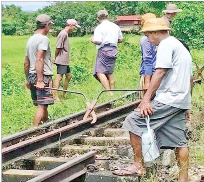
အကြမ်းဖက်သောင်းကျန်းသူအဖွဲ့၏ မိုင်းထောင်ဖောက်ခွဲမှုကြောင့် ပဲခူး-မော်လမြိုင်ရထားလမ်းပိုင်း အတွင်းရှိ သိမ်ဆိပ်နှင့် ဒုံဝန်းဘူတာအကြား မိုင်တိုင်အမှတ် ၁၂၁/၂၀-၂၁ ကြားရှိ ရထားလမ်းပျက်စီးမှုကို ပြန်လည်ဖြုတ်နေစဉ်။
