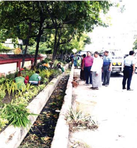
ရှိ Precast ရေနုတ်မြောင်းများ ရေစီးရေလကောင်းမွန်ရေးအတွက် မြောင်းအတွင်း ပိတ်ဆို့နေသည့် မြောင်းစာအမှိုက်သရိုက်များအား ရှင်းလင်းဖယ်ရှားပေးရန်နှင့် မြို့တော်အင်္ဂါရပ်နှင့်အညီ ဖြစ်စေ ရန်အတွက် ဆောင်ရွက်လျက်ရှိသော ပလက်ဖောင်းများ တည်ဆောက်ခြင်း၊ Precast မြောင်းဖုံးများဆောင်ရွက်ပေးခြင်းလုပ်ငန်းများနှင့် Road Curb (လမ်းကာတုံး)များအား ယာဉ်စည်းကမ်းလိုက်နာရေး ဖြူ၊ နီကျား၊ (မန္တလေးနေ့စဉ်) ၀-၀-၀-၀-၀
