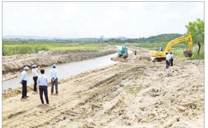
များ၌ ပြုပြင်ခြင်း၊ Structure များ တည်ဆောက်ခြင်း၊ သဲနုန်းတူးဖော်ခြင်းနှင့် ရေသွားလမ်းရှင်းခြင်း လုပ်ငန်းများကို ဆောင်ရွက်လျက်ရှိသည်။ ထိုမှတစ်ဆင့် ပြည်ထောင်စုဝန်ကြီးနှင့်အဖွဲ့သည် တပ်ကုန်းမြို့နယ် ကျောက်ဆည်ရွာအနီးရှိ
