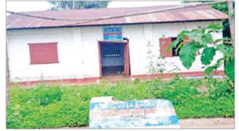
တပ်မတော်စစ်ကြောင်းများက ကြုံအင်းစိုက်ပျိုးမွေးမြူရေးနှင့် အသက်မွေးမှုအတတ်သင်စခန်း (ကောင်းမှုစခန်းခွဲ)အား သိမ်းပိုက် ရရှိမှုကို တွေ့ရစဉ်။
