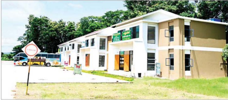
အောင်လံမြို့ အဝေးပြေးယာဉ်ရပ်နားစခန်းအဆင့်မြှင့်တင်တည်ဆောက်ထားရှိမှုကို တွေ့ရစဉ်။
