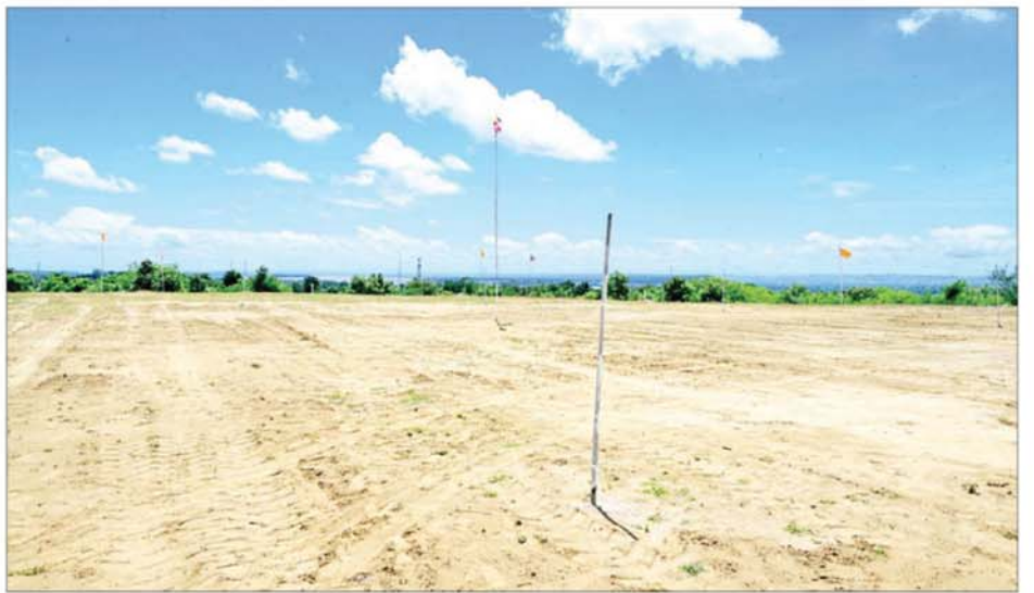
ချောက်မြို့ အမှတ်(၅)ရပ်ကွက်ရှိ စွယ်တော်မြတ်စေတီတော် တည်ထားကိုးကွယ်မည့်မြေနေရာ မြေပြုပြင်ခြင်းနှင့် မြေသားစစ်ဆေးခြင်း လုပ်ငန်းများ ဆောင်ရွက်ပြီးစီးမှုအခြေအနေများကို တွေ့ရစဉ်။
