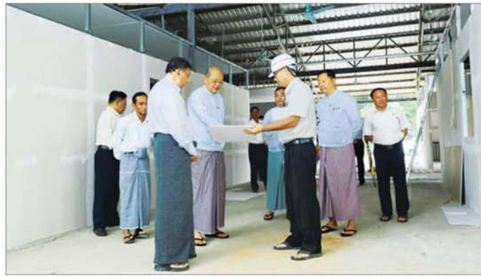
များအဆင်ပြေချောမွေ့စွာ နေထိုင်နိုင်ရန်အတွက် နေပြည်တော် အာကစား လေ့ကျင့်ရေးစခန်း၊ မိန့်ဂိတ်ဝဲ ဘယ်/ညာရှိ အဆောင် (၁၊ ၂၊ ၃နှင့် ၄)တို့တွင် နှစ်ခန်းစွဲ ဘာရာများ ဖွဲ့စည်းတည်ဆောက်နေမှုအခြေအနေများကို လိုက်လံ ကြည့်ရှုစစ်ဆေးပြီး တာဝန်ရှိသူများအား အရည်အသွေး ကောင်းမွန်
