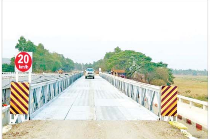
ငလျင်ဒဏ်ကြောင့် ဆွာချောင်းတံတား ထိခိုက်ပျက်စီးမှုအား ခရီးသွားပြည်သူများ အဆင်ပြေချောမွေ့ စွာ သွားလာနိုင်ရေး ပြန်လည်တည်ဆောက်ရေးလုပ်ငန်းများ ဆောင်ရွက်ထားမှုကို တွေ့ရစဉ်။
