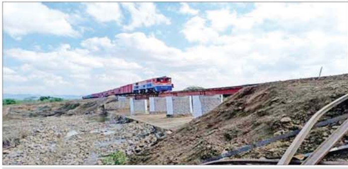
ခွေးရုပ်-ဆင်တောင်ကြား တောင်ပြိုမြေများကို ဖယ်ရှားရှင်းလင်းဆောင်ရွက်ပြီးစီးမှုကို တွေ့ရစဉ်။
